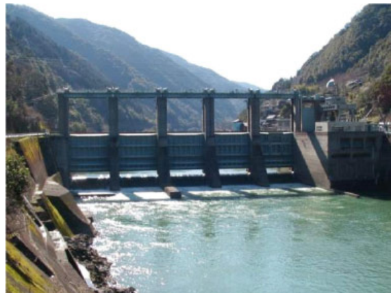
ゲート全開時の瀬戸石ダム
