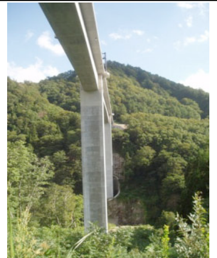
湖底から見上げる巨大橋脚
