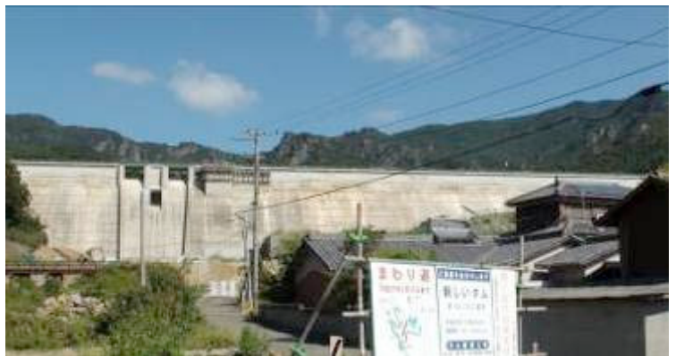
民家にすぐ迫る新内海ダム 2012/9/26
