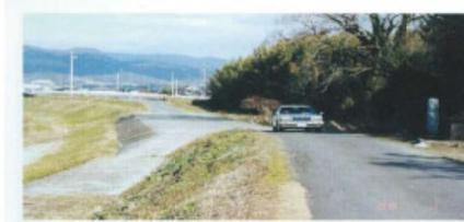
〇城原川の野越 (佐賀県神埼町撮影) 洪水時に水が堤防を越流するところを撮影するために作られた野越。写真裏の堤防が、一旦決壊している。本書第4章。(大熊孝撮影)
