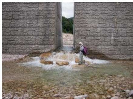
写真右側上は 3 回目切り下げ時。同下側はダム下流側、洗堀防止のための石組工法。スリット幅やスリットの形には課題が残るが、この大きさのダムに河床までスリットを入れたことは評価できる。既設ダムへの河床までスリットを入れる改修は始まったばかりだが、この動きを全国に広げるべきだと考えている。
