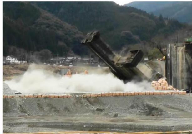
(左写真) 制御発破による右岸みお筋部(堤体上流上部左岸側)撤去(14年12月10日)
