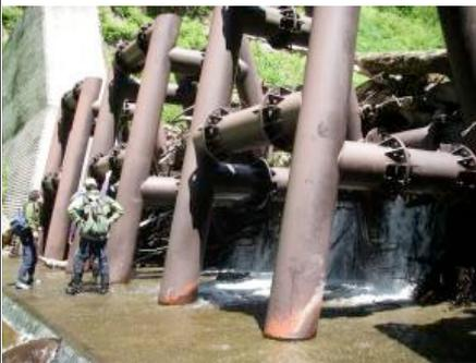
もともとのこのダムの建設理由は、2kmくらい上流側で大きな山腹崩壊が起こり、高さ20mくらいの天然ダムが生じた。国側はこのダムが決壊することで生じる土石流の害を防ぐためのものであるという
