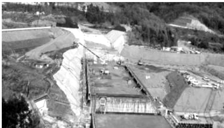
急ピッチで進む本体工事 左は旧内海ダム堰堤 11.4.9
