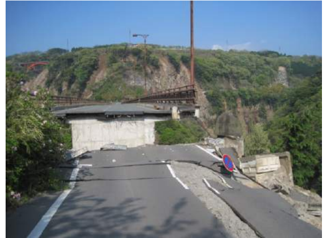
(写真6)ダム水没予定地周辺の地すべり (写真7)地すべりで破損した長陽大橋西側の道路
