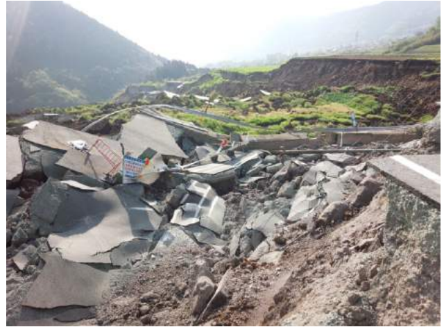
(写真4)ダム本体予定地上流の土砂崩壊
