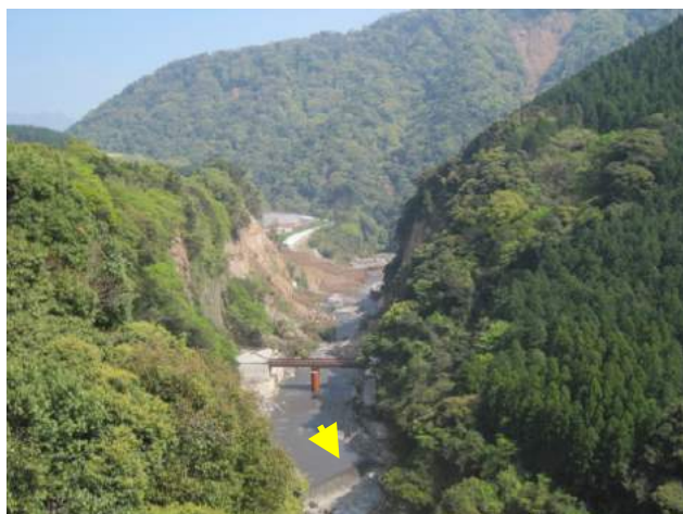
（写真1）下流側から見たダム本体予定地
