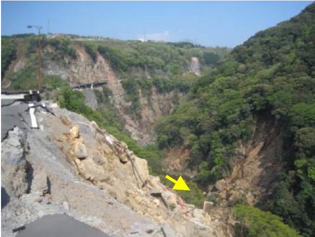
(写真6)ダム水没予定地周辺の地すべり (写真7)地すべりで破損した長陽大橋西側の道路
