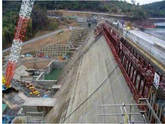
図 4.6.52 下の原ダム嵩上げ事例
