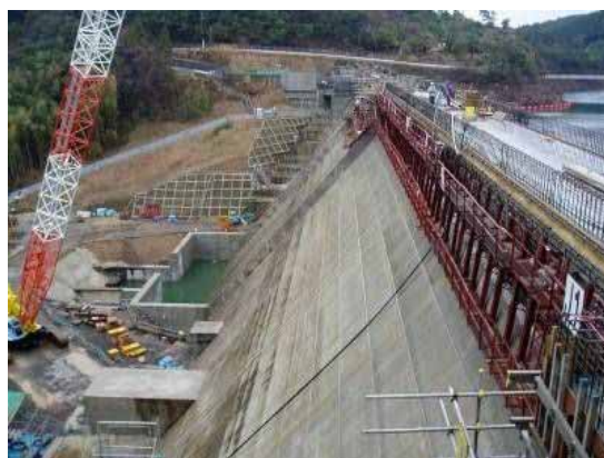
図 4.6.11 下の原ダム嵩上げ事例
