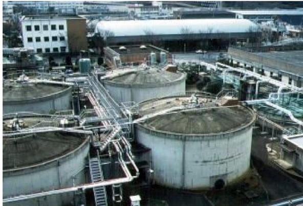
図 8.16 汚泥消化槽（中部下水処理場）
