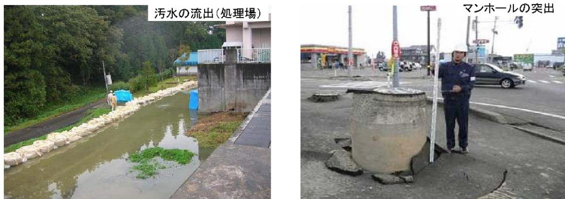
図 8.6 新潟県中越地震における下水道施設の被害の状況
