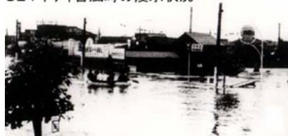
S24キティ台風時の浸水状況
