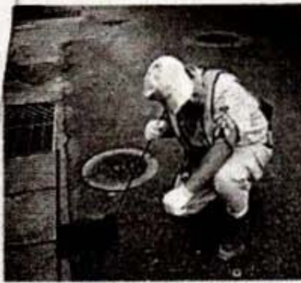
水道管に音調棒をあてて水漏れを調査する水道局職員
