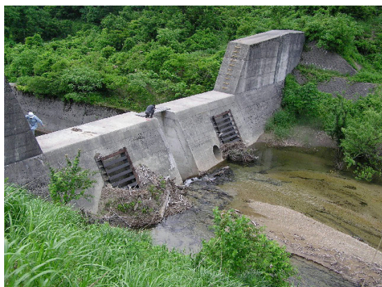
既存砂防ダムのスリット化改修
