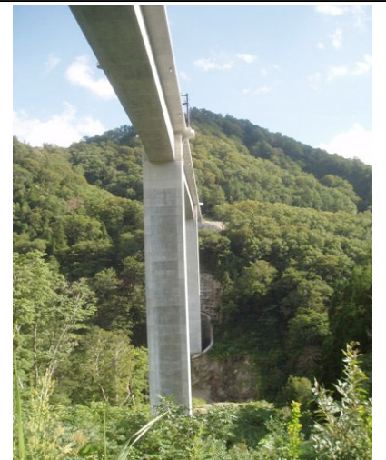
湖底から見上げる巨大橋脚
