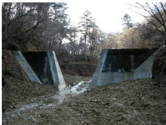
既存治山ダムの中央部撤去（V字型）
