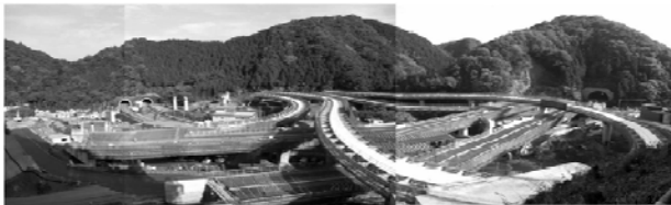
圏央道・南インターJCT(高尾山側から撮影)
