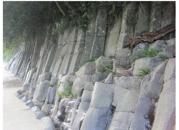
割れ目だらけの立野ダム予定地の地盤
