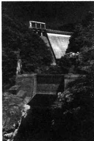
▲1967年に竣工(完成)した矢木沢ダム。利根川最上流部に位置する。関東地方では最大級のダムといえる。群馬県みなかみ町に位置する藤原ダム。利根川本流に建設された大規模ダムとしては歴史が古く(1959年竣工)、支流の玉原ダムを上池として揚水発電を行なっている。主に原発の夜間電力など、余った電力により上池(玉原ダム)にポンプアップし、下池(藤原ダム)に戻す際に落差を利用して発電するのが揚水発電。よって原発との結びつきが強いダムといえる。
