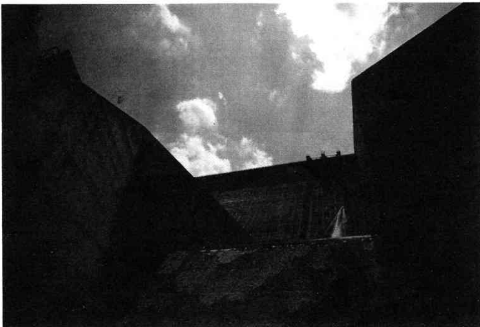
▲利根川支流の神流川本谷に2005年竣工した上野ダム。信濃川水系の南相木川(南相木ダム)を上池、上野ダムを下池として揚水発電を行う高さ120mの巨大ダム。揚水発電とは、発電調節が不得手な原発の余剰電力(夜間電力)を利用して上池へとポンプアップし、電力需要の増加する昼間に下池に水を落として発電するもの。つまり原発の稼働を前提として計画されたダムなのだが、原発の停止により稼働率は低下したまま。ちなみにポンプアップには揚水発電で得られる出力の3割増しの電力が必要になるとか。ムダに電力を浪費するダムになり果てた
