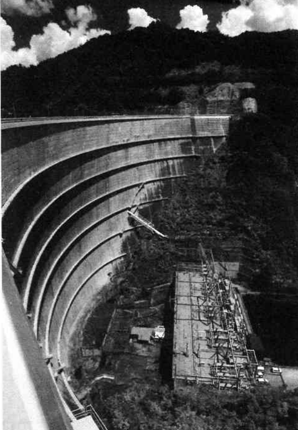
▲1967年に竣工(完成)した矢木沢ダム。利根川最上流部に位置する。関東地方では最大級のダムといえる。群馬県みなかみ町に位置する藤原ダム。利根川本流に建設された大規模ダムとしては歴史が古く(1959年竣工)、支流の玉原ダムを上池として揚水発電を行なっている。主に原発の夜間電力など、余った電力により上池(玉原ダム)にポンプアップし、下池(藤原ダム)に戻す際に落差を利用して発電するのが揚水発電。よって原発との結びつきが強いダムといえる。
