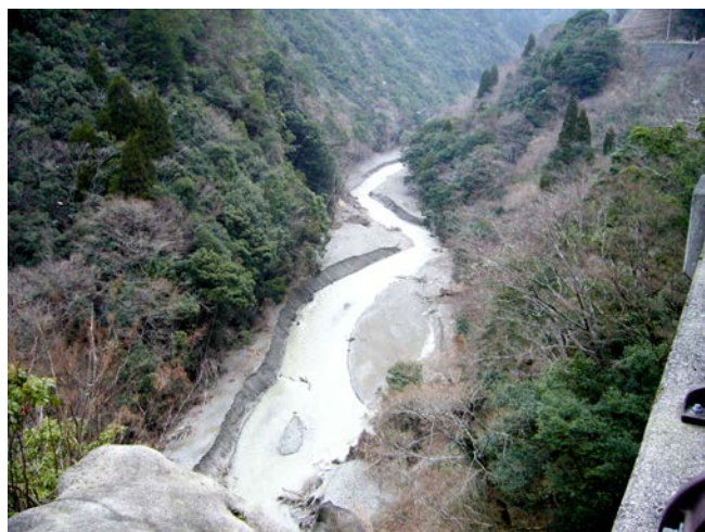
朴木砂防ダム堰堤上流から見た同ダム上流部（2006/3/2） 堆 うずたか く堆積した灰色のシルトを分けるように濡筋 みおすじ がある。今回の見学ではこの両岸に積もったシルトは跡形もなかった。
