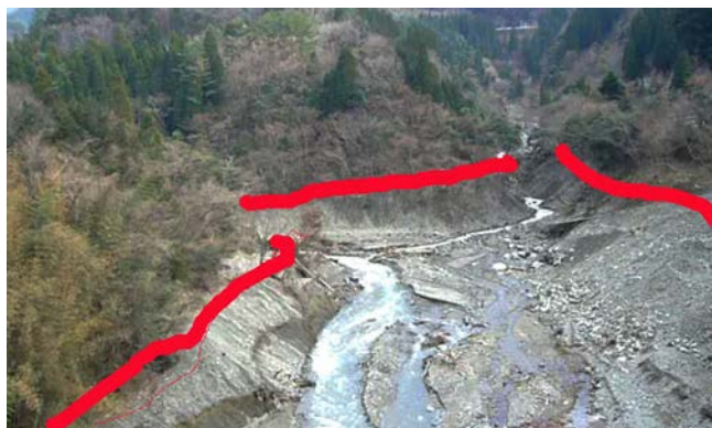
縦木川砂防ダム堰堤の橋からみた同ダム直上流部（2006/3/2） 灰色のシルトの層を縫うように濡筋 みおすじ がある。山腹崩壊直後は土砂とシルトが赤い線の下まで堆積していたので、その殆どが流出したことが分かる。今回の見学ではシルトは全くなかった。
