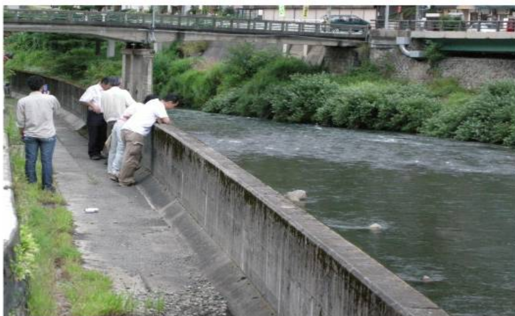
写真 瀬見温泉の嵩上げ堤防（パラペット堤防） ※2
