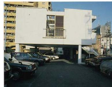
○洪水時に被害がないようピロティ構造を採用
