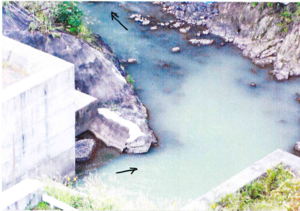
太田川ダム直下放水路の白濁
