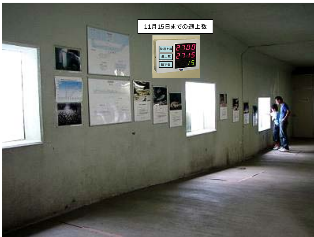
図 9. 電光掲示板の設置
