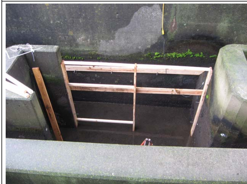
写真 3. センサー部土台設置③
