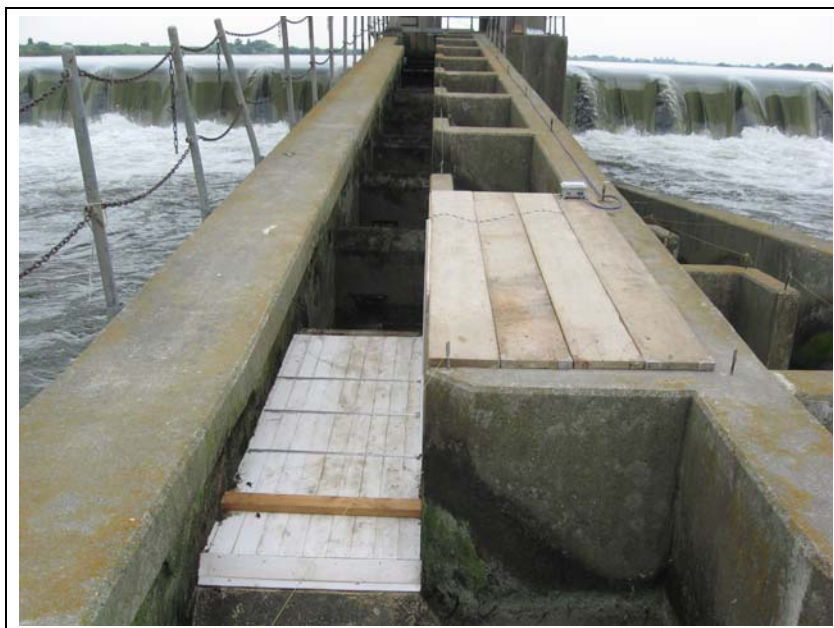
写真 25. センサー部土台設置⑦
