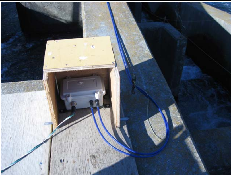
写真 42. 配線作業 場所：3号魚道センサー部
