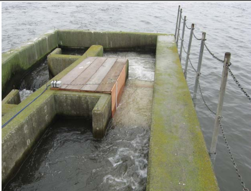
写真 41. 配線作業 場所：3号魚道階段部
