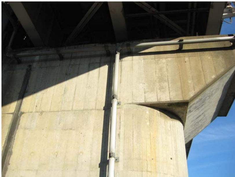
写真 17. センサー部の配線②
