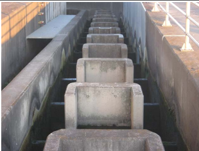
写真 48. 1号魚道部の撤去
