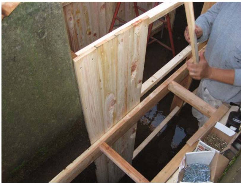
写真 7. センサー部土台設置⑦
