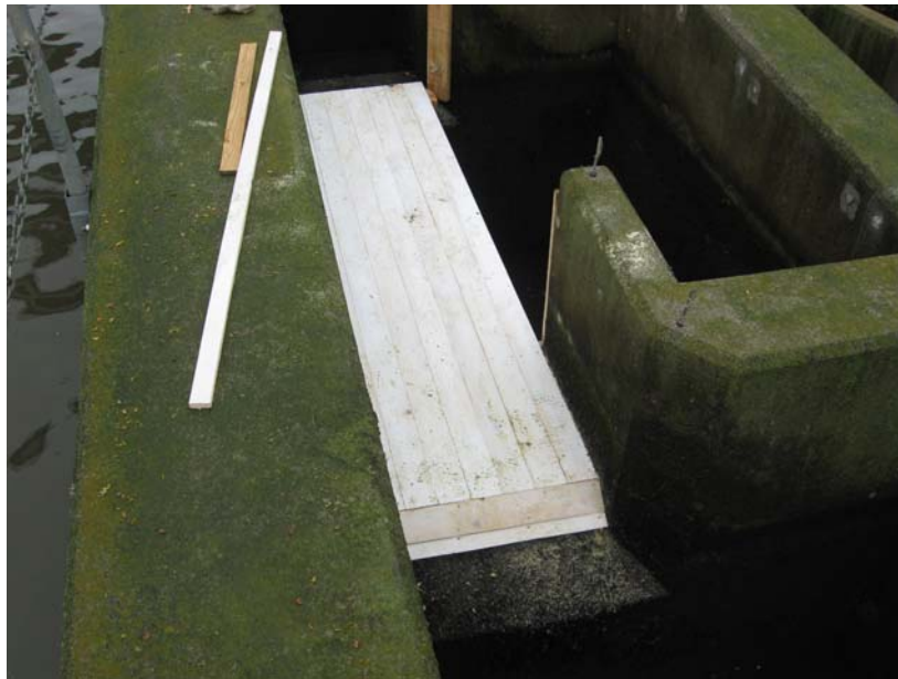
写真 27. センサー部土台設置⑤ 場所：3号魚道隔壁部
