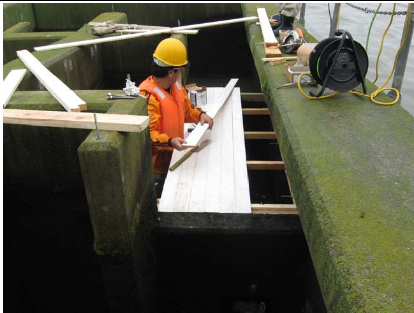
写真 35. センサー部土台設置③ 場所：3号魚道隔壁部
