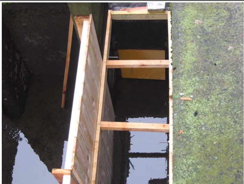
写真 5. センサー部土台設置⑤
