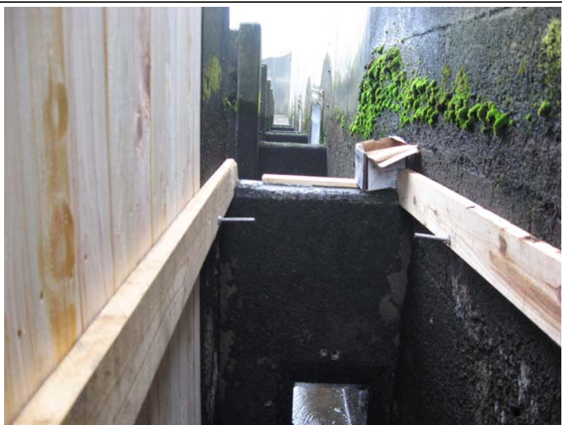
写真 4. センサー部土台設置④
