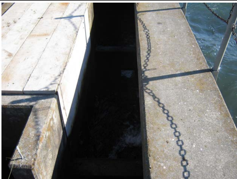
写真 48. 3号魚道部の撤去
