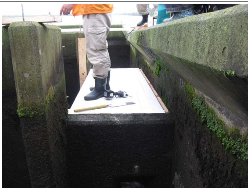
写真 21. センサー部土台設置③
