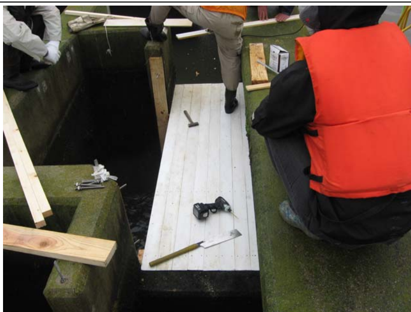
写真 36. センサー部土台設置④ 場所：3号魚道隔壁部
