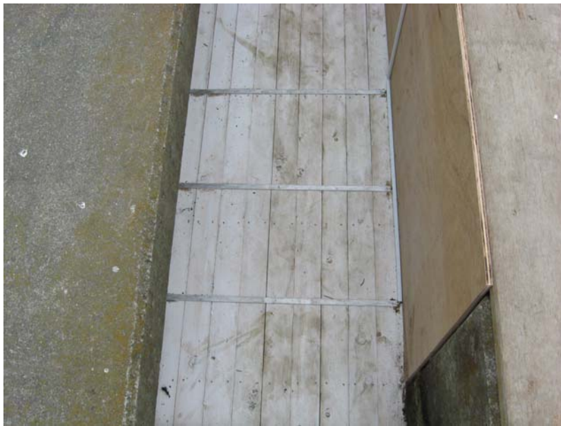
写真 23. センサー部土台設置⑤
