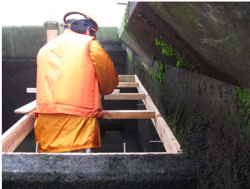
写真 34. センサー部土台設置② 場所：3号魚道隔壁部
