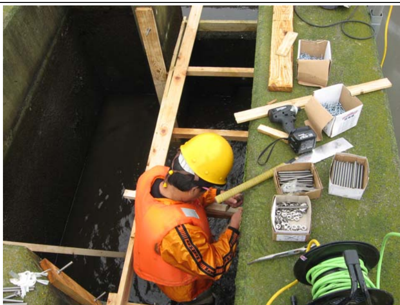
写真 20. センサー部土台設置②
