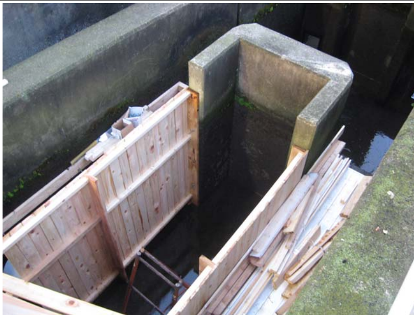
写真 8. センサー部土台設置⑧
