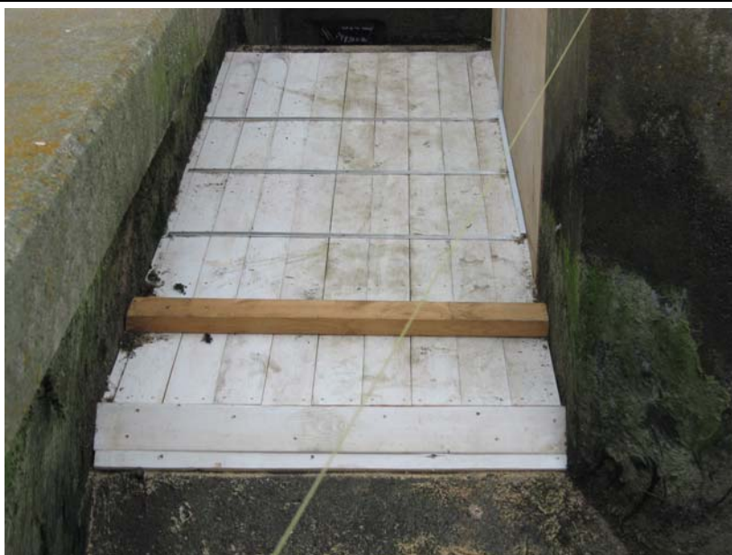
写真 24. センサー部土台設置⑥
