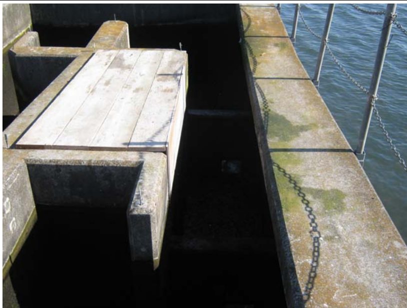
写真 48. 2号魚道部の撤去
