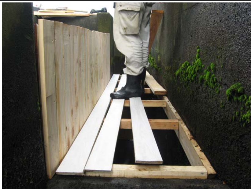
写真 6. センサー部土台設置⑥
