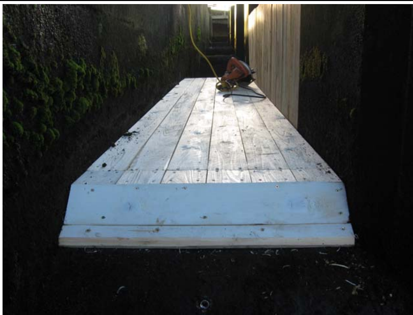
写真 9. センサー部土台設置⑨
