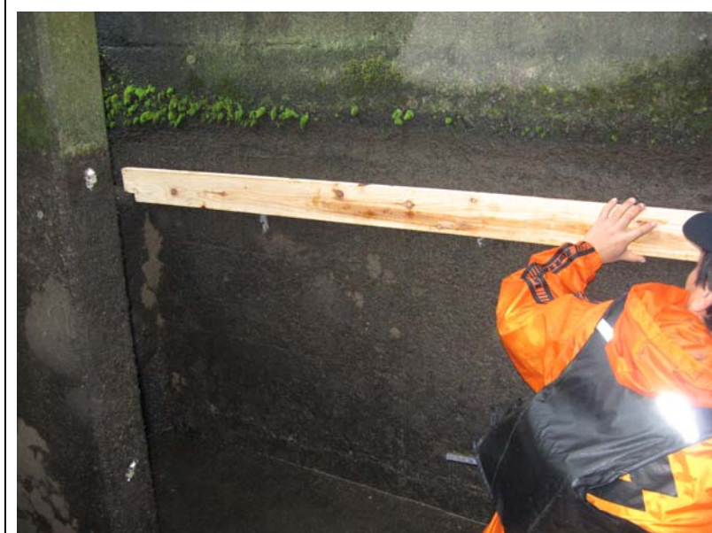
写真 2. センサー部土台設置②
