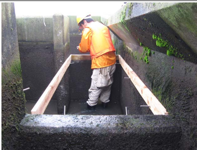
写真 19. センサー部土台設置
