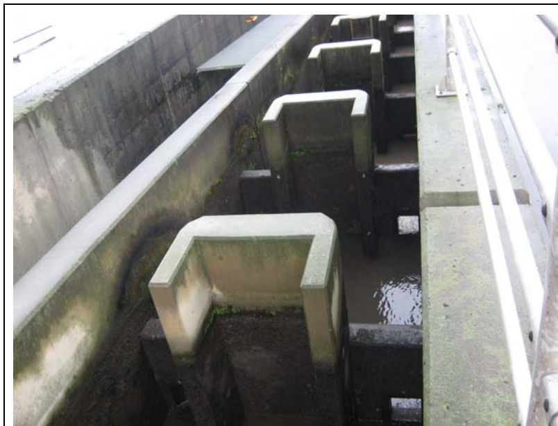
写真 1. センサー部土台設置①
