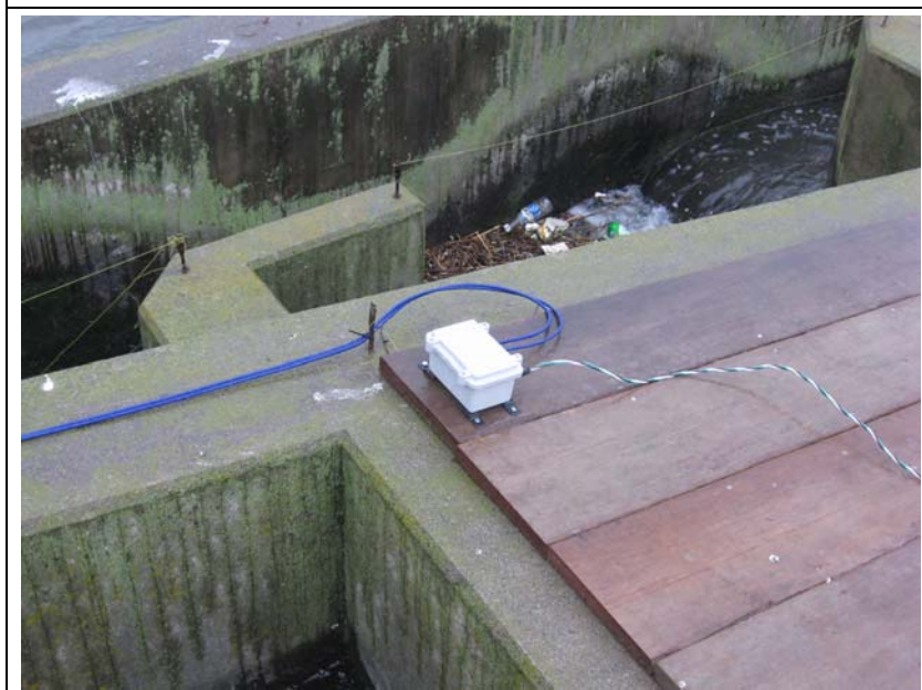
写真 26. 計測装置設置
