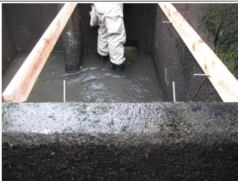
写真 33. センサー部土台設置
