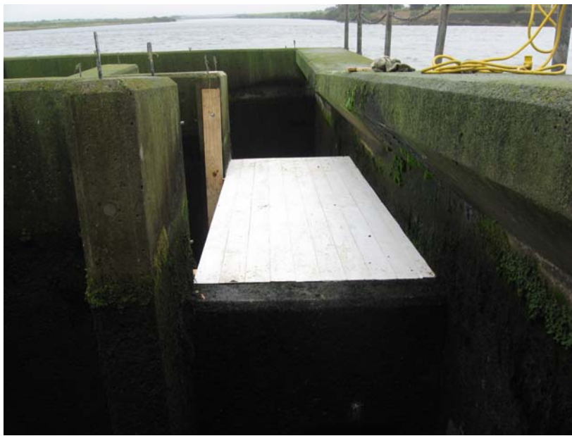
写真 22. センサー部土台設置④
