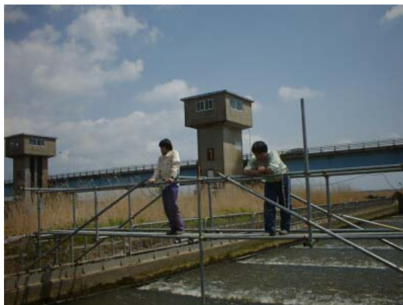
目視調査状況
