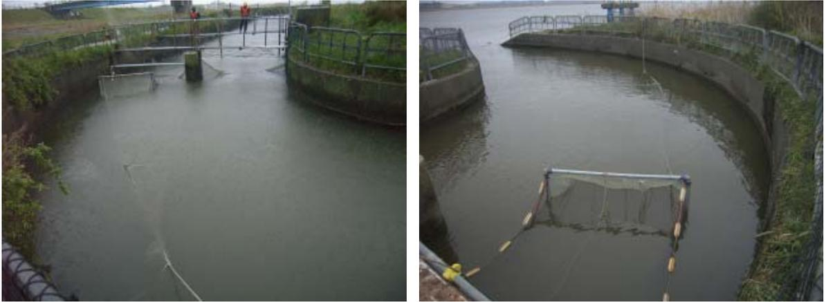
写真 2.3.1 魚道上流におけるふくろ網設置状況
