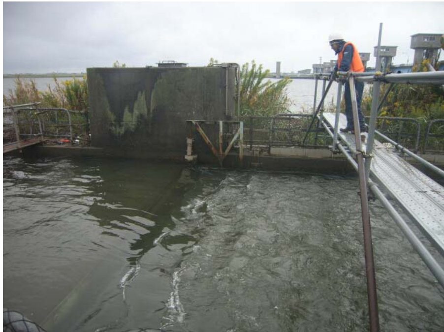
写真 6.3.1 目視調査状況
