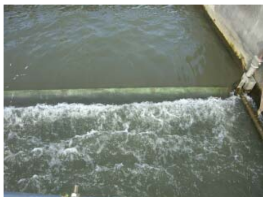
写真 4.3.1 隔壁上端の状況 左:順流時 右:逆流時
