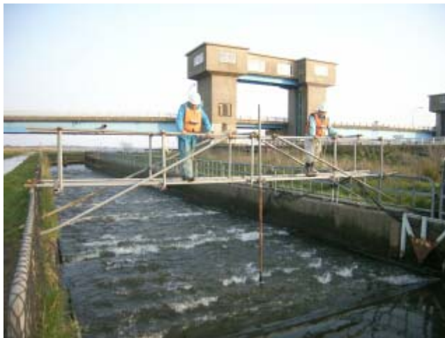
写真 3.5.2 平成 19 年 4 月 13 日における左岸側の目視状況
