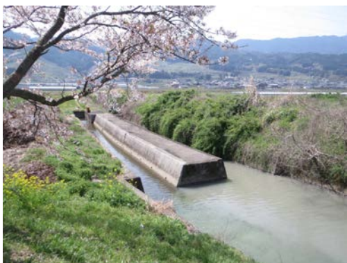
下流の深迫川右岸堤防
