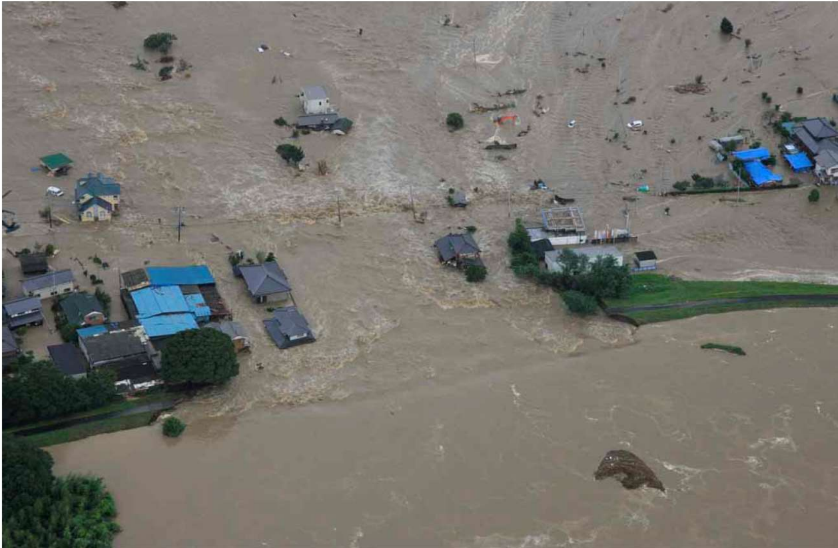
写真1 茨城県常総市 鬼怒川決壊状況（平成27年9月10日 撮影：国土交通省関東地方整備局）
