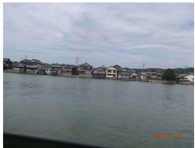
(写真1) 川棚川最下流部左岸の低い堤防と立ち並ぶ建物 (2018年7月1日撮影)
