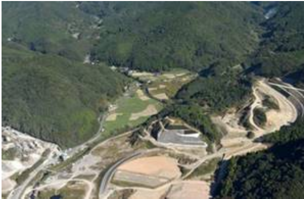
(写真) 石木ダム建設予定地＝長崎
