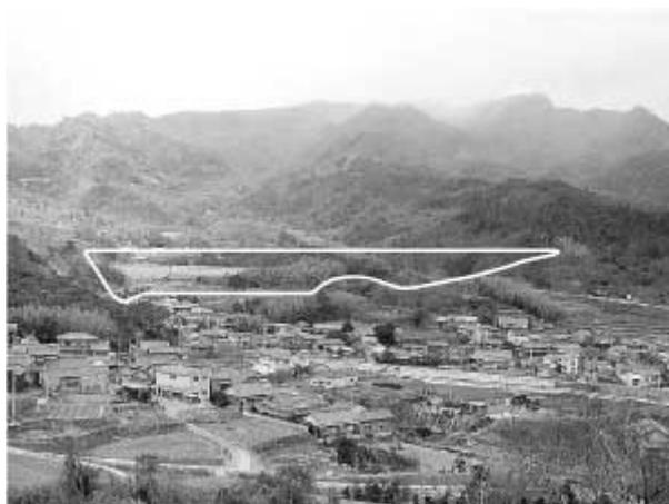
図1 内海ダム再開発想定図 白い線で囲まれている部分がダム堤体。堰堤長は447mにもなる。
