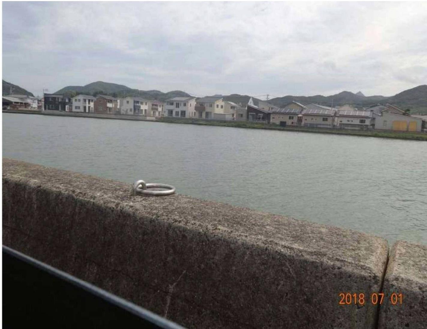
(写真2) 川棚川最下流部右岸の低い堤防と立ち並ぶ建物
