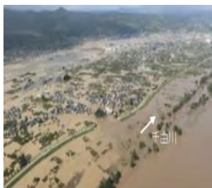
令和元年東日本台風 による長野市穂保地 先の堤防決壊、浸水 被害状況
