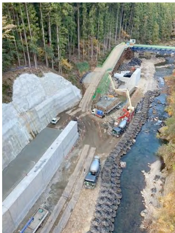
右岸側で、河道の付け替え工事が進行中、分厚いコンクリート 3 面張りの河道が完成間近。
