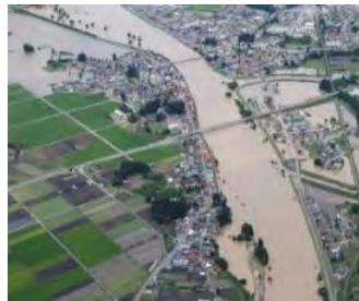
令和2年7月豪雨 による山形県大石 田町の浸水被害状 況
