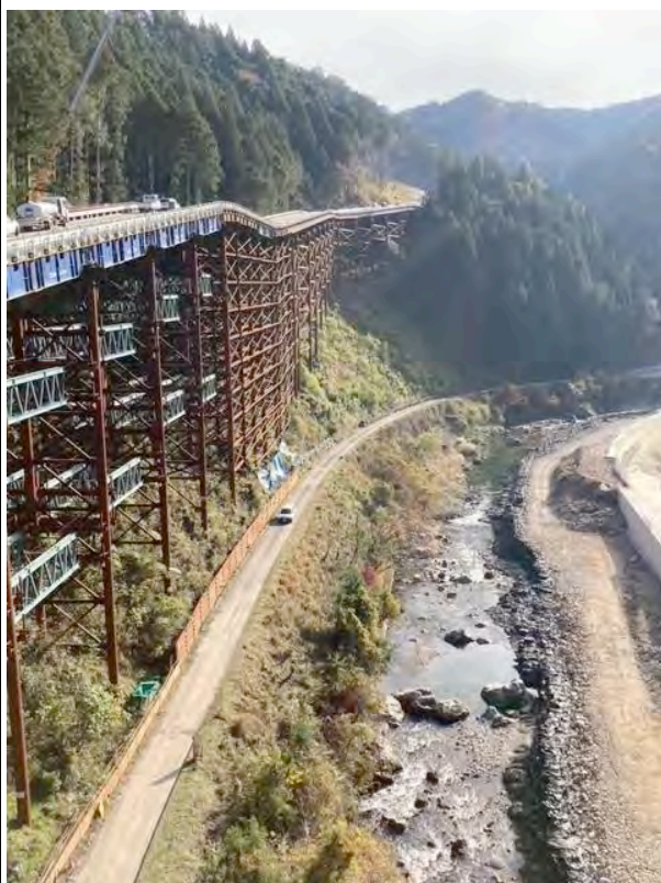
ほぼ同じ位置の現在の風景 左岸斜面は大規模地すべりブロックで工事用道路は斜面が使えず、完全鉄骨造り。
