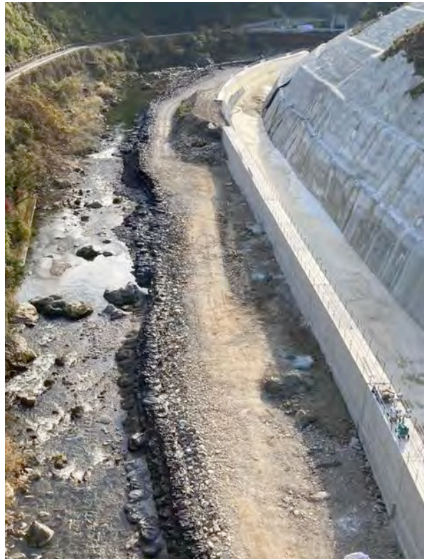
下流側をみる。コンクリート張りの付け替え河道が右端、中は工事用の道路、左が河道。
