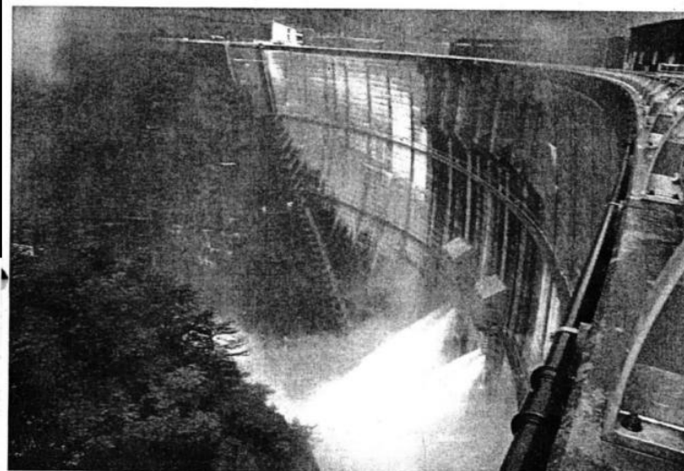
強雨の中、洪水調節で放流する川治ダム＝9月9日午後3時、日光市川治温泉川治（国交省鬼怒川ダム統合管理事務所提供）
