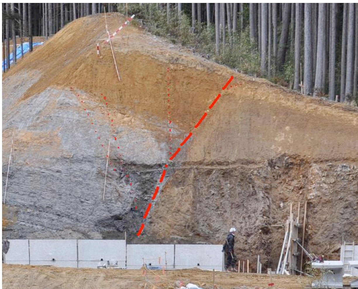
写真 1 設楽町田口地区西部の道路工事のり面に現れた断層。2016 年 4 月 2 日 筆者撮影。 表層の風化層まで、変位させていること、また、上盤側が上昇している地形が読み取れる。
