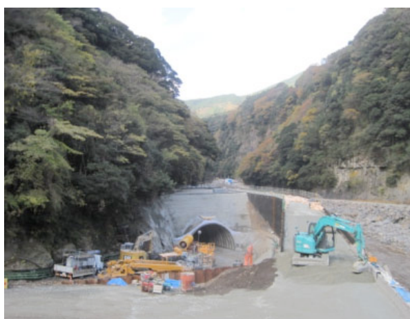
立野ダム仮排水路トンネル工事。 奥の V 字谷にダム本体が造られようとしている
