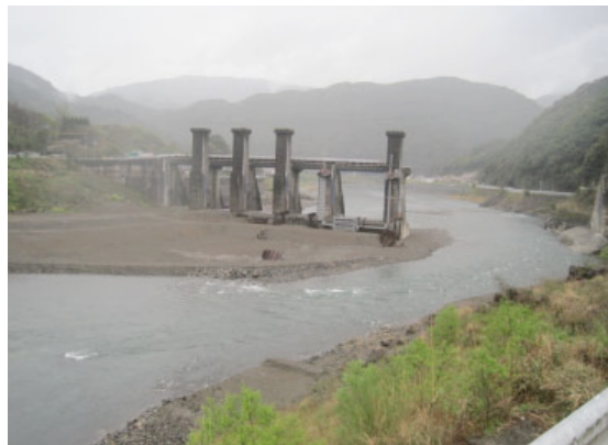
右岸側が撤去された荒瀬ダム 2015.4.3 撮影
