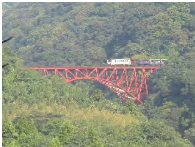
阿蘇北向谷原始林と南阿蘇鉄道のトロッコ列車。 立野ダムができれば北向谷原始林は水没し、 この見事な鉄橋も掛け替えられる。
