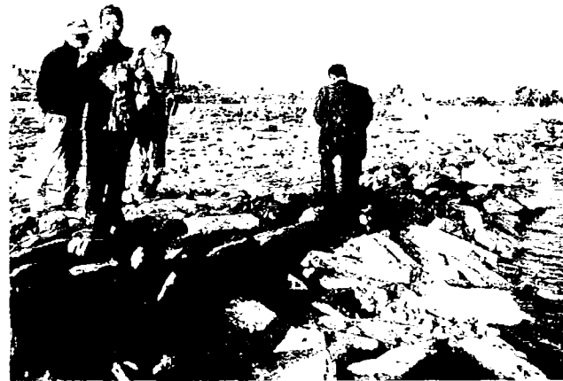
2004年10月の台風23号で土や草木が押し流され、青石組みが現れた吉野川第十堰 (2004年12月)
