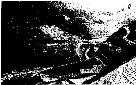
地滑りの進行を食い止めるため、斜面の基部を大量の土砂で固定する工事が行われた。7月、秩父市大滝で
