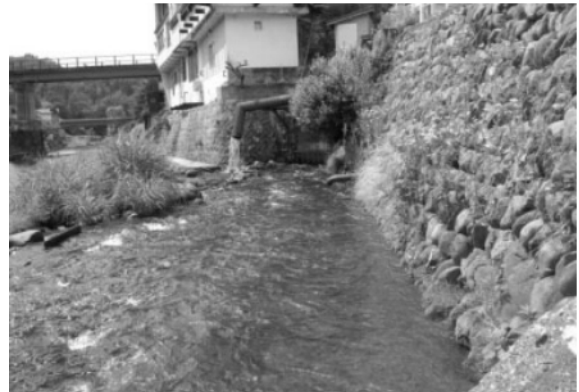
虹の橋上流 右岸側の石積護岸
