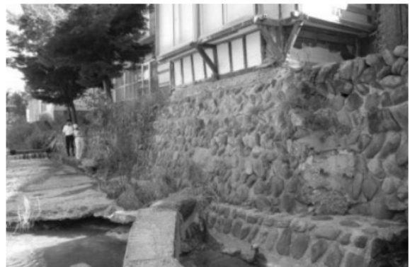
三之巫旅館裏の石積護岸
