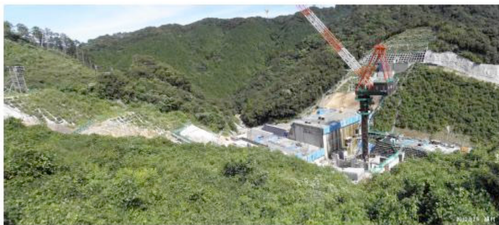
豊かな照葉樹林が生い茂るど真ん中で本体工事が強行される路木ダム
