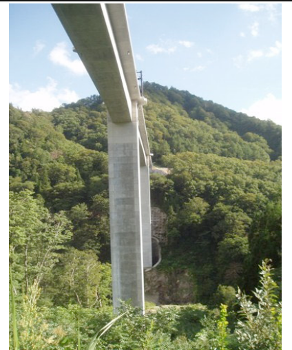
湖底から見上げる巨大橋脚
