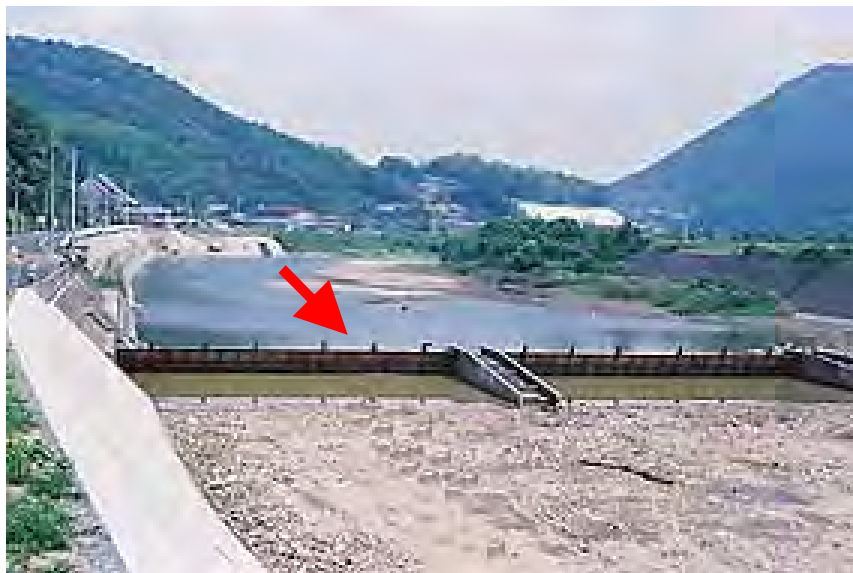
山道堰(川棚川 平成6年9月)
