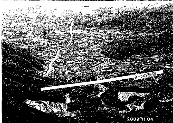
寒霞溪の展望台から見た新内海ダム堰堤位置(白線)直下下流の住居状況 (寒霞溪の自然を守る連合会作成)
