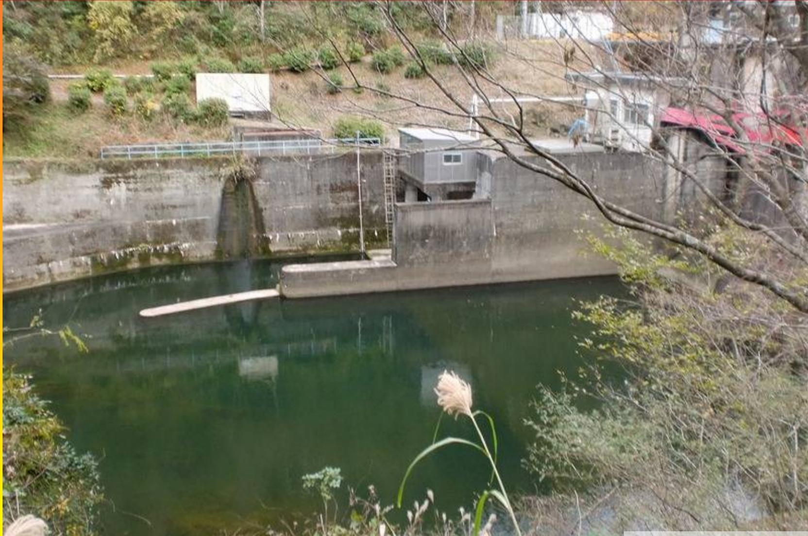
水越ダム：菅野ダムの逆調整地ダム（菅野ダムからの放流量が発電のため、時間変化が大きいので、一定の流量にするために下流に設けたダムで、水越ダムでも発電を行っている。）
