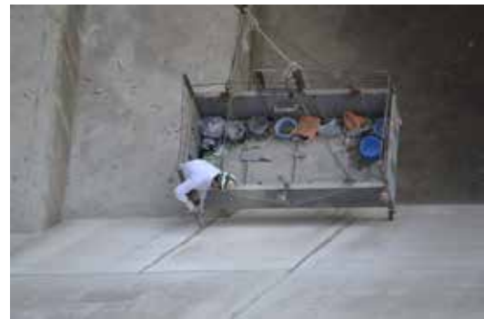
2014/3/15 亀裂を埋める作業
