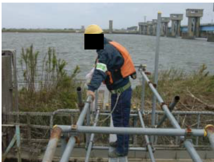
目視調査状況
