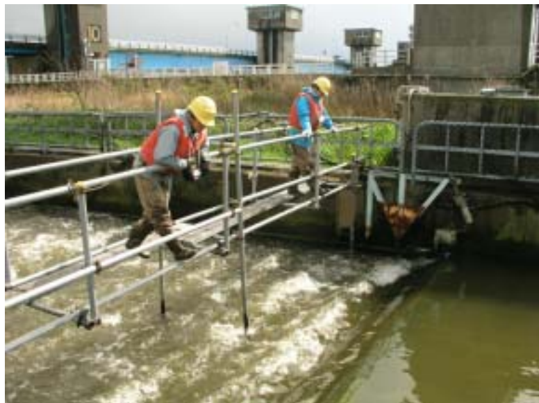
目視調査状況
