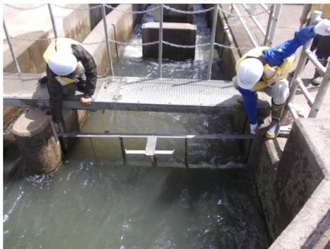
角落とし部にうけ取付用枠を設置
