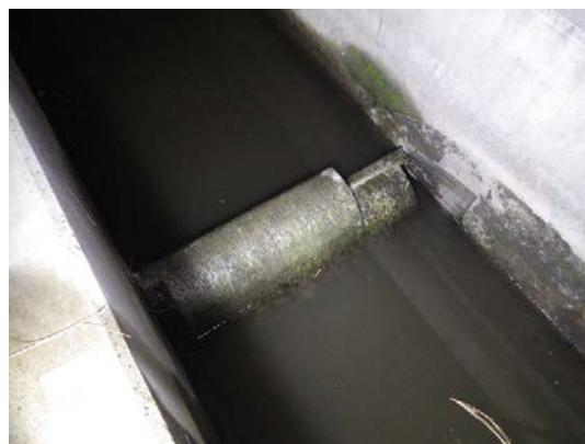
越流部の様子（23:13）
