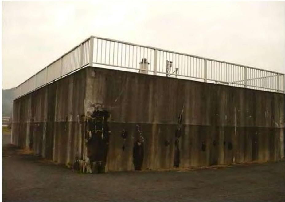
図 4.5 配水池の老朽化状況
