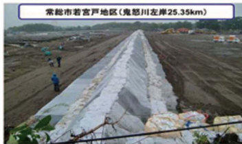
9月16日 大型土のう設置終了 (L=209m)
