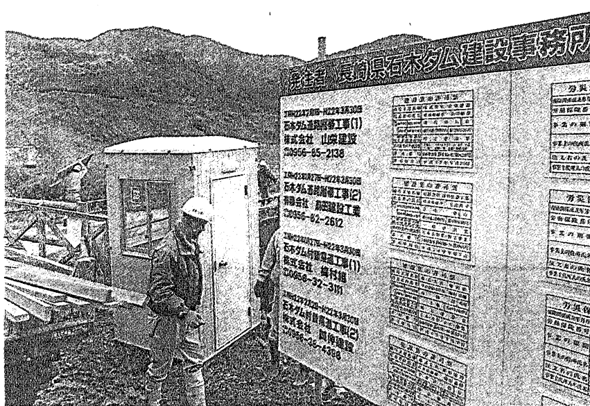
看板やプレハブの設置など付け替え道路の工事に向け準備を進める作業員 —24日午後2時42分、川棚町若屋郷
