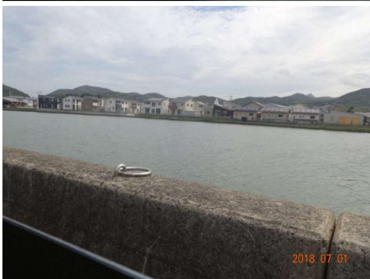
（写真 2）川棚川最下流部右 岸の低い堤防と立ち並ぶ建物 （2018 年 7 月 1 日撮影）
