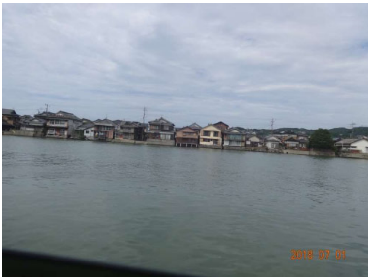
（写真 1）川棚川最下流部左 岸の低い堤防と立ち並ぶ建物 （2018 年 7 月 1 日撮影）
