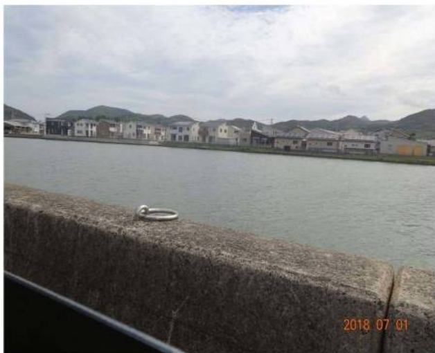
(写真2) 川棚川最下流部右岸の低い堤防と立ち並ぶ建物 (2018年7月1日撮影)
