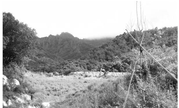
現ダム堤体のすぐ下で転流工工事が進んでいます。ダム直上流に野積みされている掘削土。土石流の原因になるので緊急に除去を求める。
