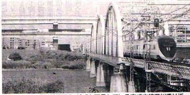
荒川堤防で高さが周辺より3.7メートル不足している京成本線荒川橋付近。2018年度から対策工事が始まる＝国土交通省荒川下流河川事務所提供
